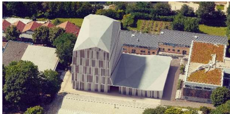
Nouveau bâtiment de l'ESTP
