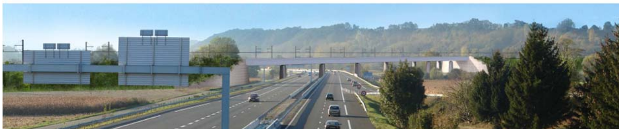
Perception du viaduc de franchissement de la Bourbre et de l'A43
